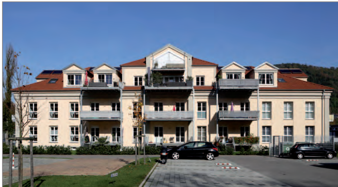
Auf einem alten Kasernengelände in Lahr wurden 350 Wohnungen saniert und 100 Bauplätze erschlossen. Den ursprünglichen Charakter hat die Falk-Gruppe beim Parkdomizil Hohbergsee wunderbar erhalten und aufgewertet.
