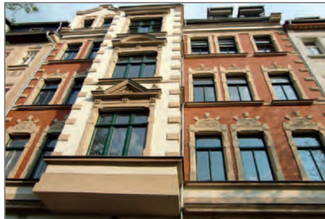
Falk war federführend bei der denkmalgerechten Modernisierung der Patrizierhäuser mitten in Leipzig.
